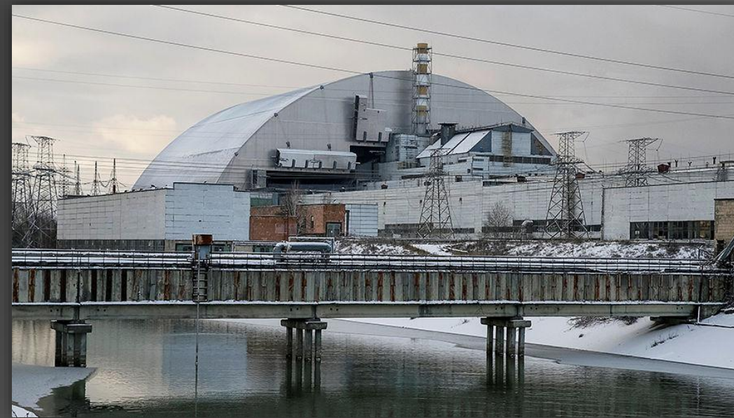
Саркофаг над четвертим енергоблоком ЧАЕС
