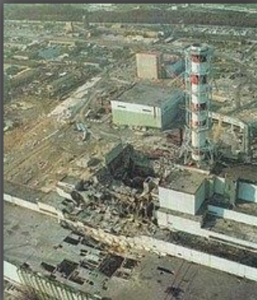
Зруйнований четвертий енергоблок ЧАЕС
