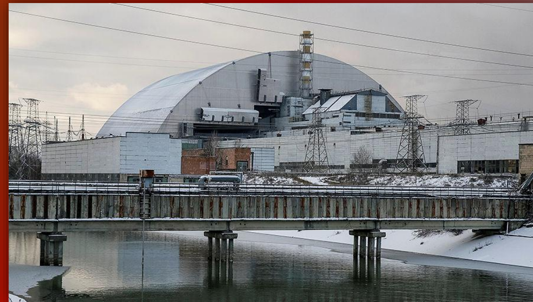
Саркофаг над четвертим енергоблоком ЧАЕС
