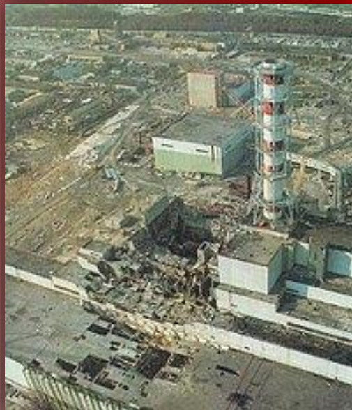
Зруйнований четвертий енергоблок ЧАЕС
